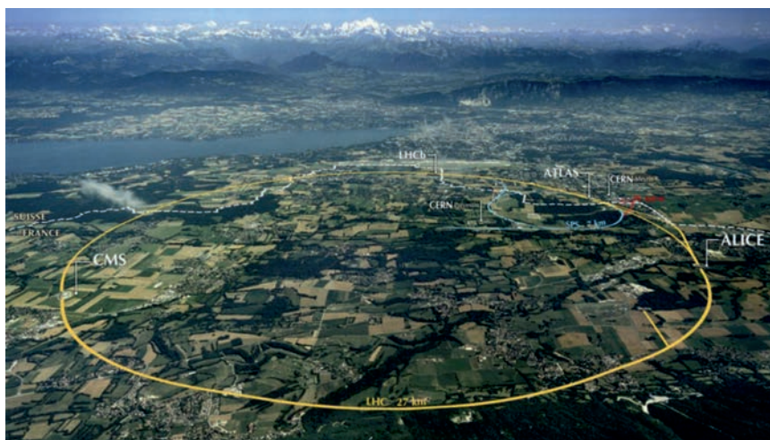
Рис. 7.18. Территория ЛНС в ЦЕРН (вид сверху)
